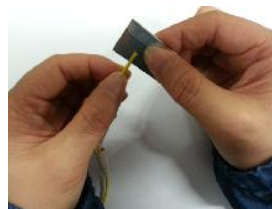
5/ 用刀片将光缆外皮劈开6mm。
